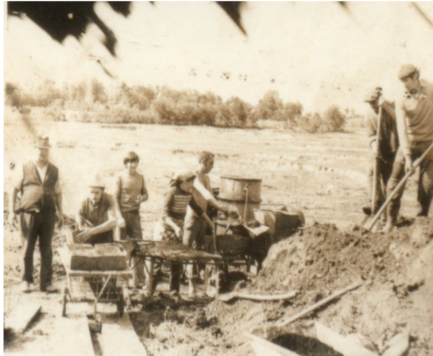
Cărămidarii din Andrid lucrând cu utilaje
