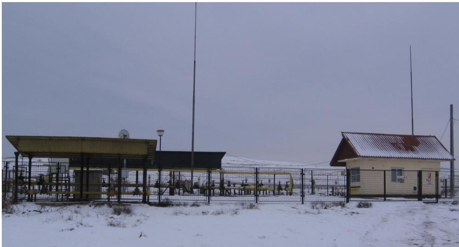
Stația de gaz din Poiana Codrului
