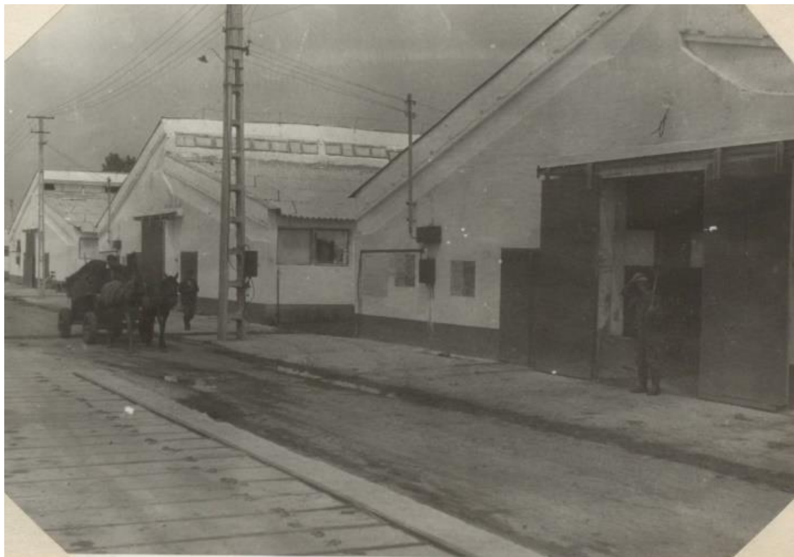
Grajduri noi construite în anul 1983
