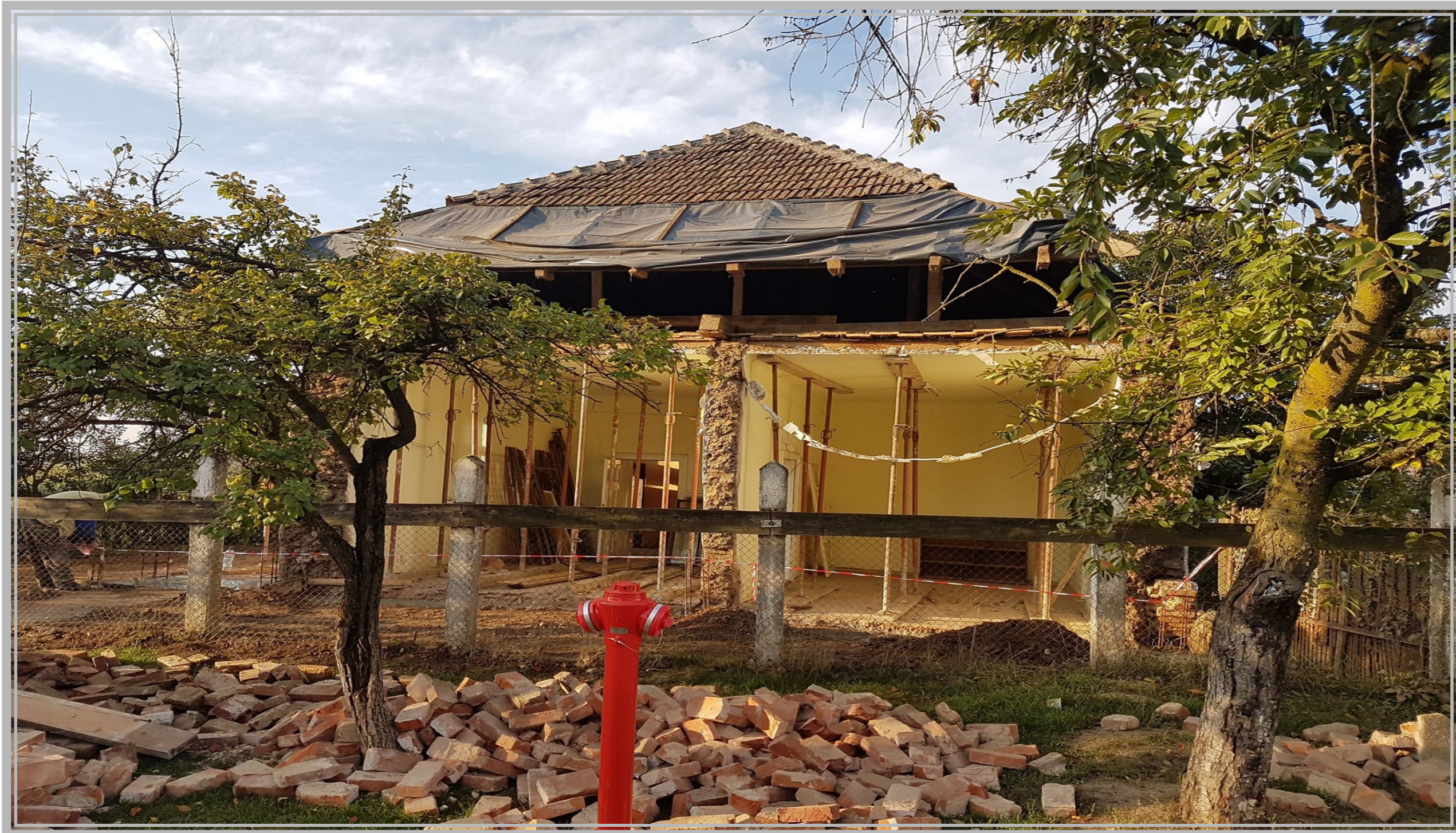
Biblioteca Comunală Moftin, reparații, 2018
