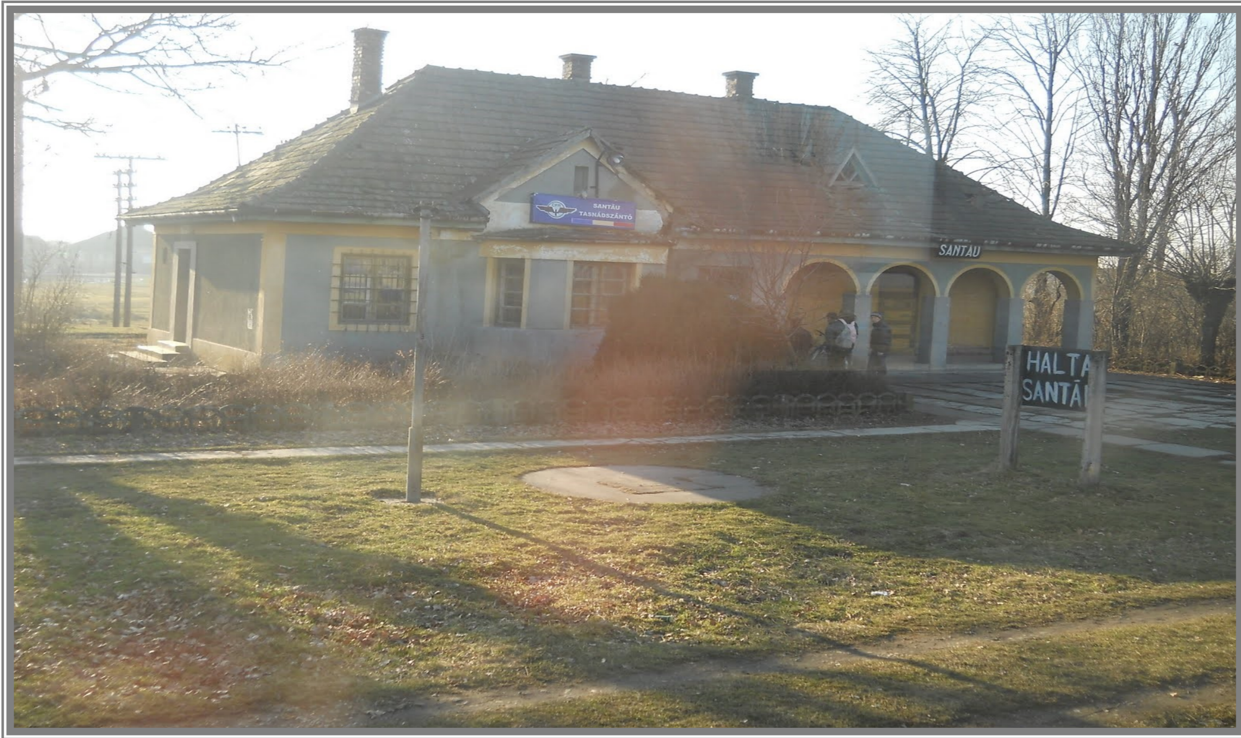
Vechea gară din Santău, demolată în anii 2000
