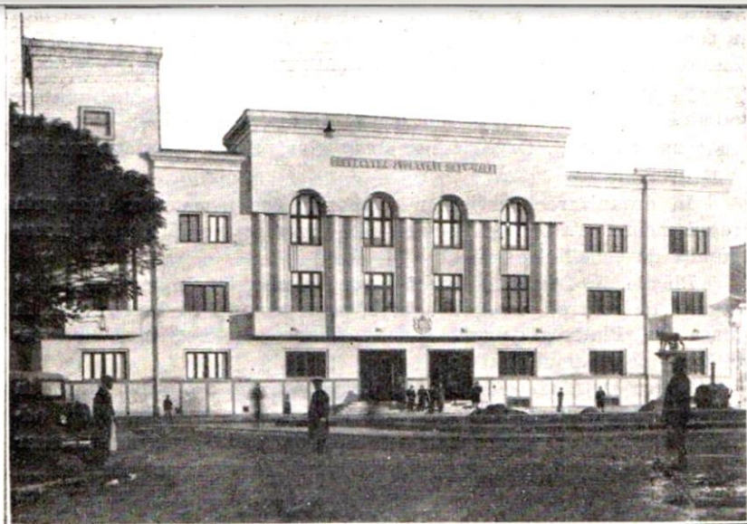
Noul palat administrativ construit 1935—1936. — Cea mai impunătoare clădire publică ridicată sub
