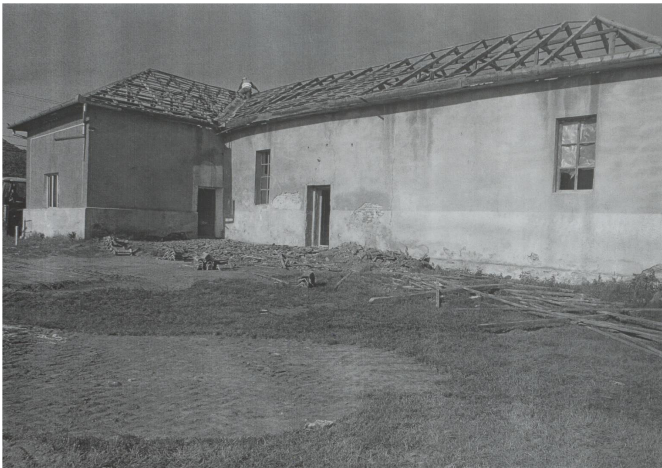
Căminul cultural din Giorocuta. Vechea clădire în timpul demolării
